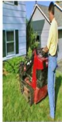
Dig the Trench
